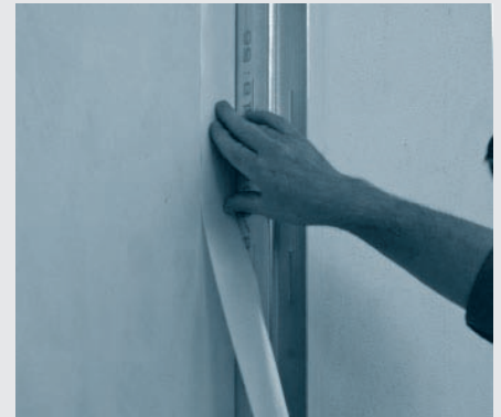
3 pav. Knauf Trenn-Fix juosta galima klijuoti tiesiog prie lygaus statybinių konstrukcijų paviršiaus.
