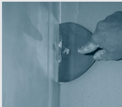
5 pav. Sumontavus plokštę, siūlė užglaistoma.
