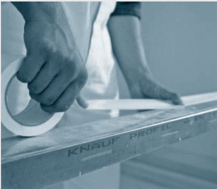
1 pav. Lipnioji Knauf Trenn-Fix juosta klijuojama prie CW ir UW profilių.
