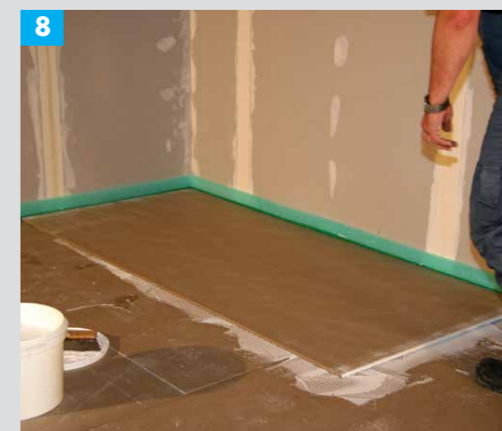
8 Antrą Knauf BROWN plokščių sluoksnį dėti skersai ant pirmo sluoksnio.
