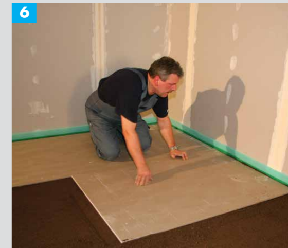
6 Ant paruošto visiškai sulyginto barstalo iš pradžių išilgai, greta viena prie kitos sandariai vienu sluoksniu kloti Knauf BROWN gipskartonio plokštes.
