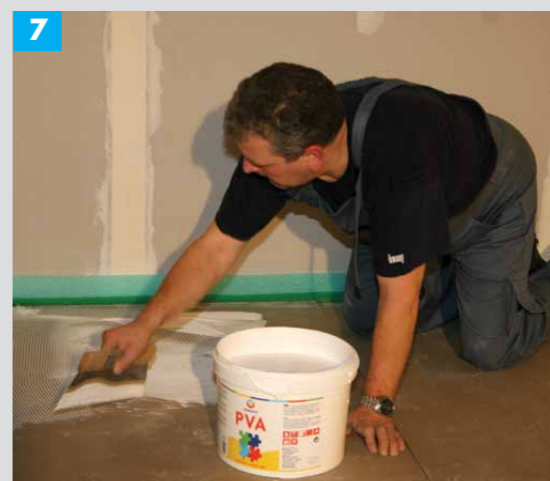
7 Prieš dengiant viršutinį sluoksnį, pirmo sluoksnio plokštes dantyta 3 mm mentele padengti PVA klijais.
